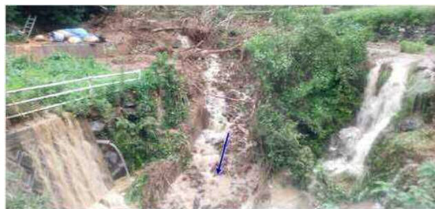
③ 被害想定区域末端部
